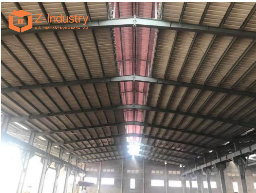
Hoàn thiện lợp mái
