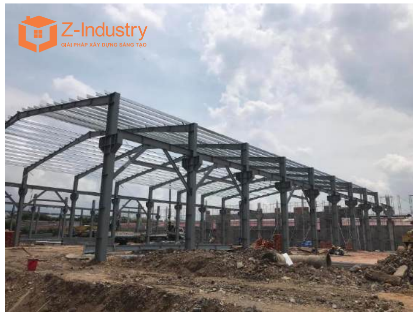
Lắp dựng xà gồ
