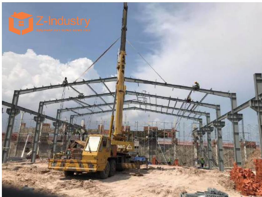
Lắp dựng hệ vì kèo
