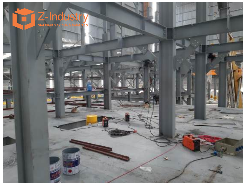
Gia cố hệ kết cấu
