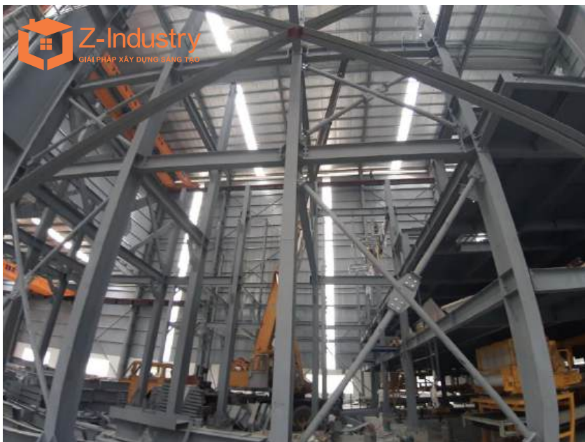
Hoàn thiện hệ kết cấu
